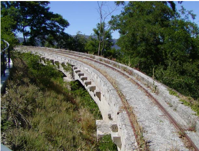
ponte in cemento armato in frazione Piani
